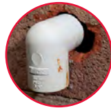
Réparation à la structure (exclusion)
